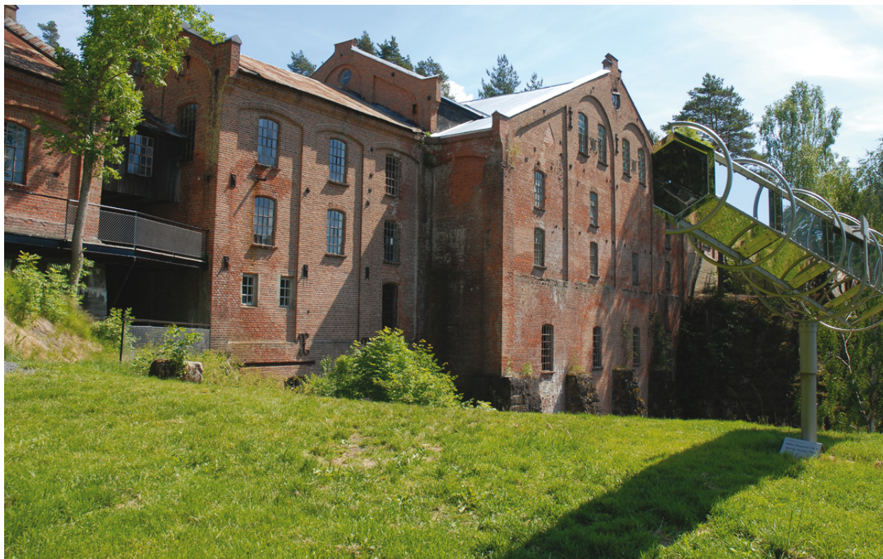
Den gamle tresliberibygningen ved Kistefos-museet, med skulpturen «Viewing Machine» (2001) av Olafur Eliasson i forgrunnen.
